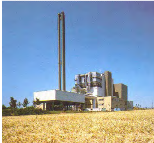
- Abb. 2 - Kaum wieder zu erkennen - das MHKW 1984
